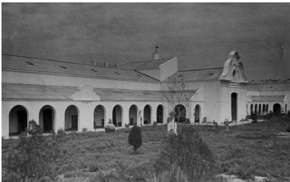
IMAGEN N°4. Pabellón Gnecco con las obras avanzadas – Sin fecha.
