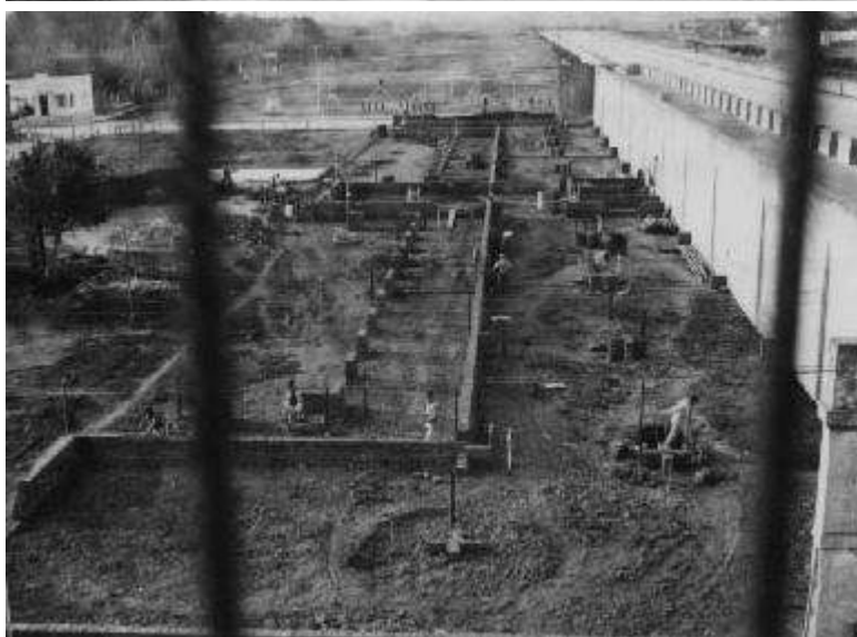
IMAGEN N° 2 y 3. Etapas de la construcción del Pabellón Gnecco (posiblemente de 1946).
